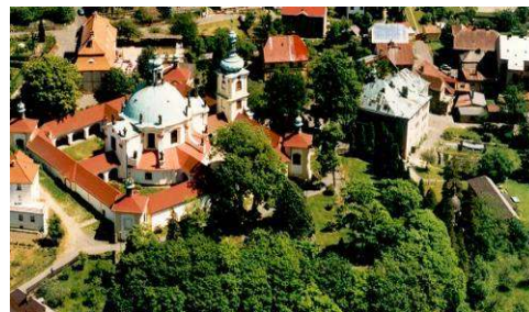
Kaple Panny Marie v těsné blízkosti DOZP
